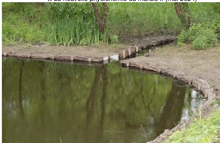
2. Protection des berges du marais II restauré par des fascines (mai 2024)
