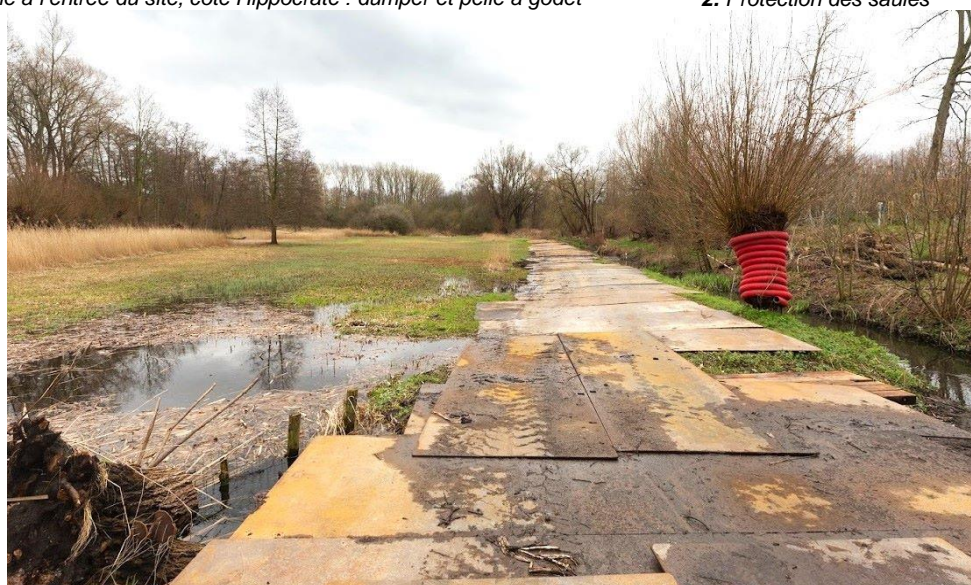
4. Plaques de répartition, le long de la prairie humide, vers l'amont, ici à hauteur du second barrage
